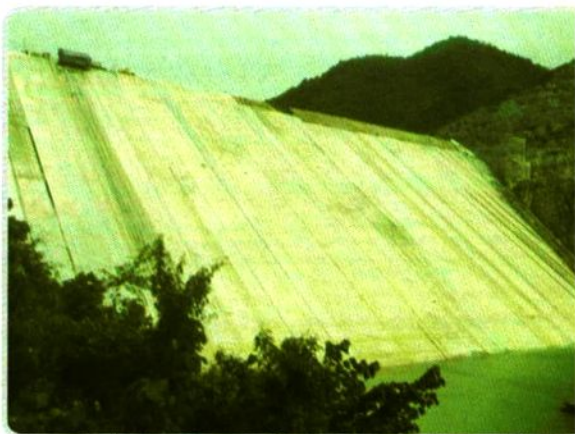
我国最高的钢筋混凝土面板坝——西北口水库大坝
