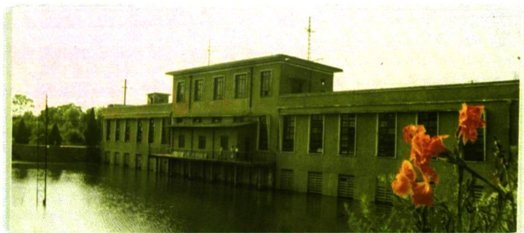
枝江市江口泵站
