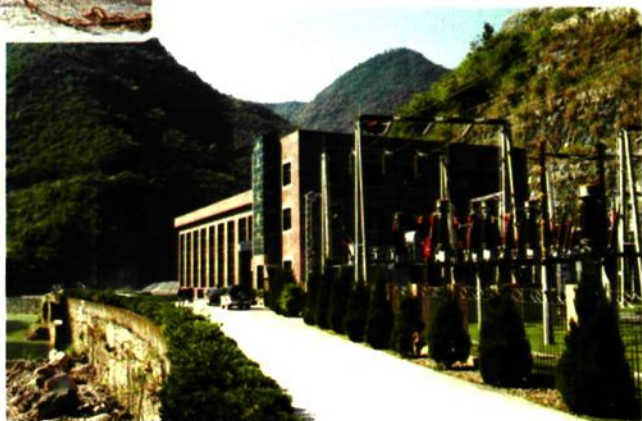
宜昌市西北口水电站
