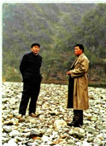
原宜昌行署顾问闫锦华（右）与原宜昌地区水利电力局局长郑金才在西北口水库工地检查工作
