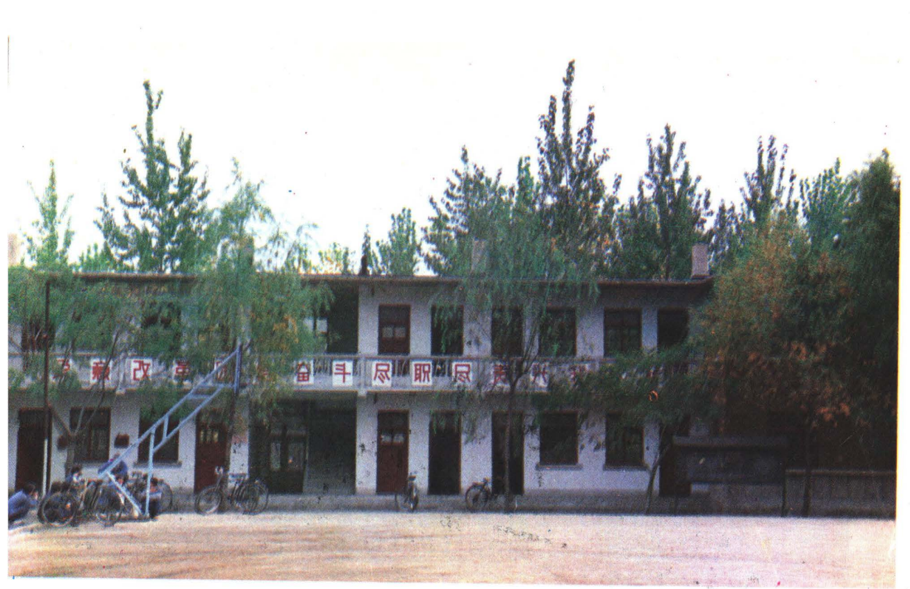
图 3 — 1 采矿车间办公楼
