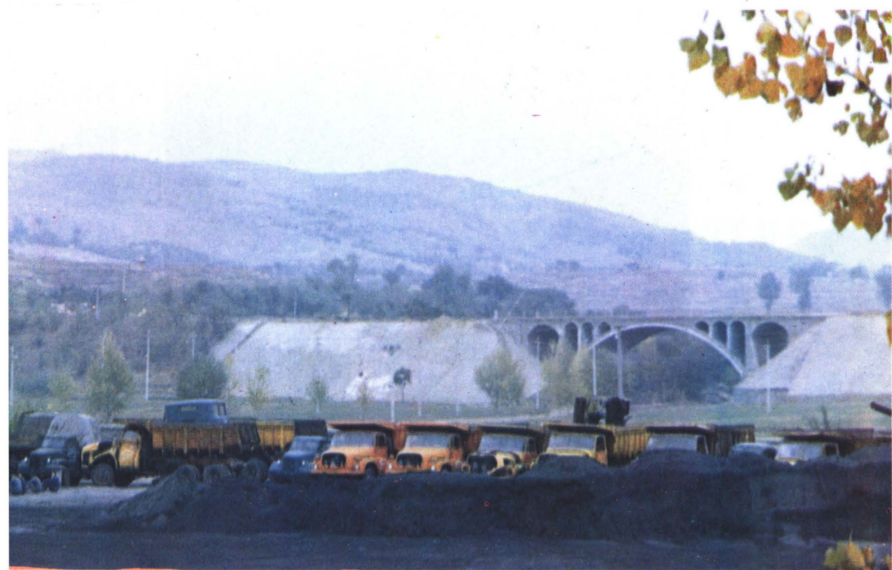
图 3—11 运输车间停车场精矿储备场及原矿运输大桥
