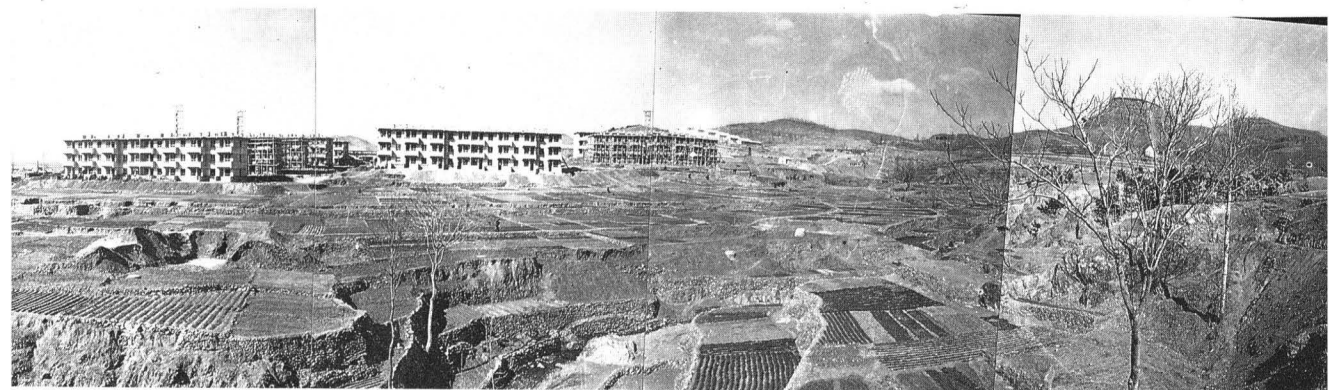
图 1—16 正在施工中的家属楼地貌
