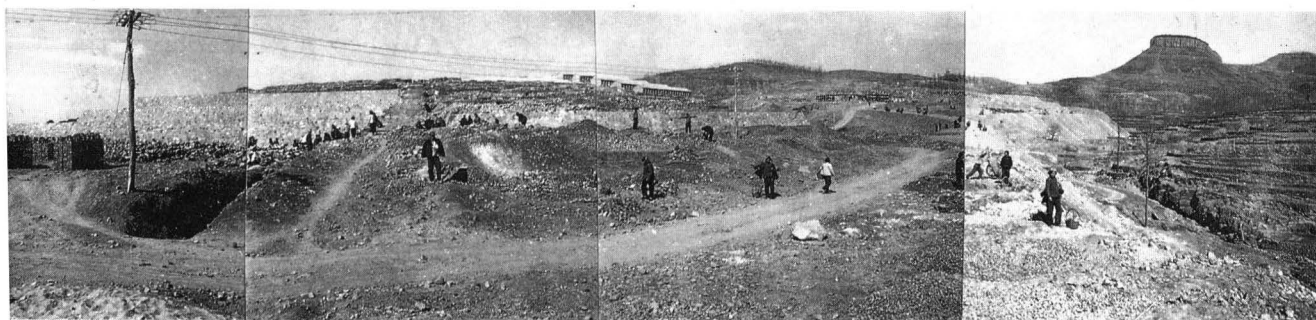
图 1—9 筹建初期生活区的“三通一平”现场地貌
