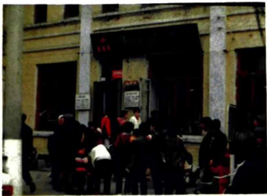
1954—1955法院旧址（奋斗路221号）
