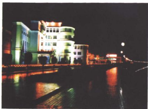
▲墨江河堤建设局路段
