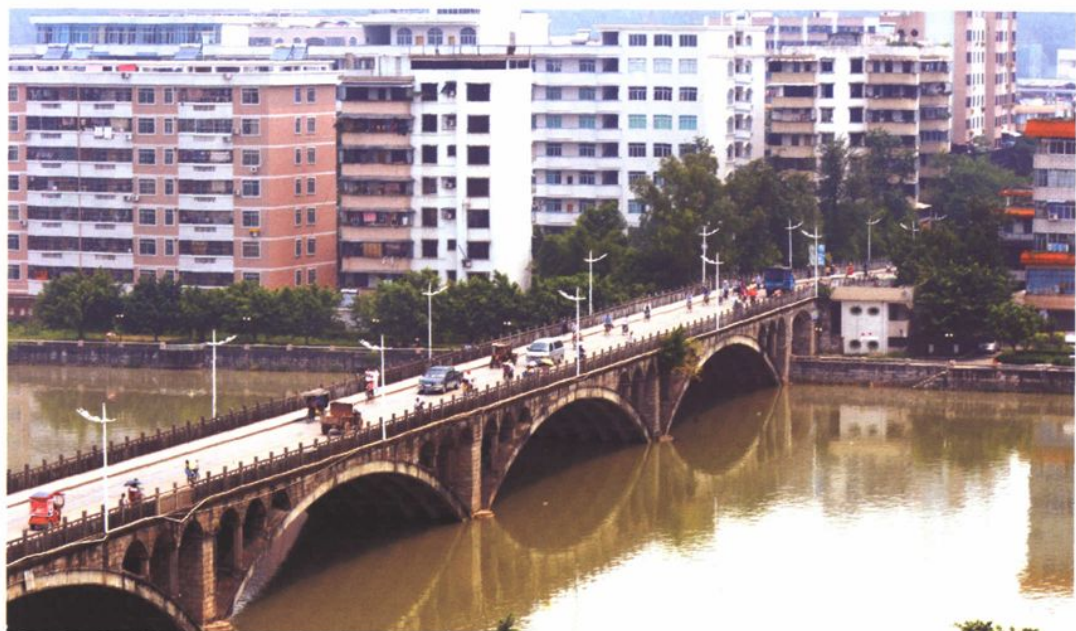
▲ 始兴县墨江大桥（谢义雄 摄）
