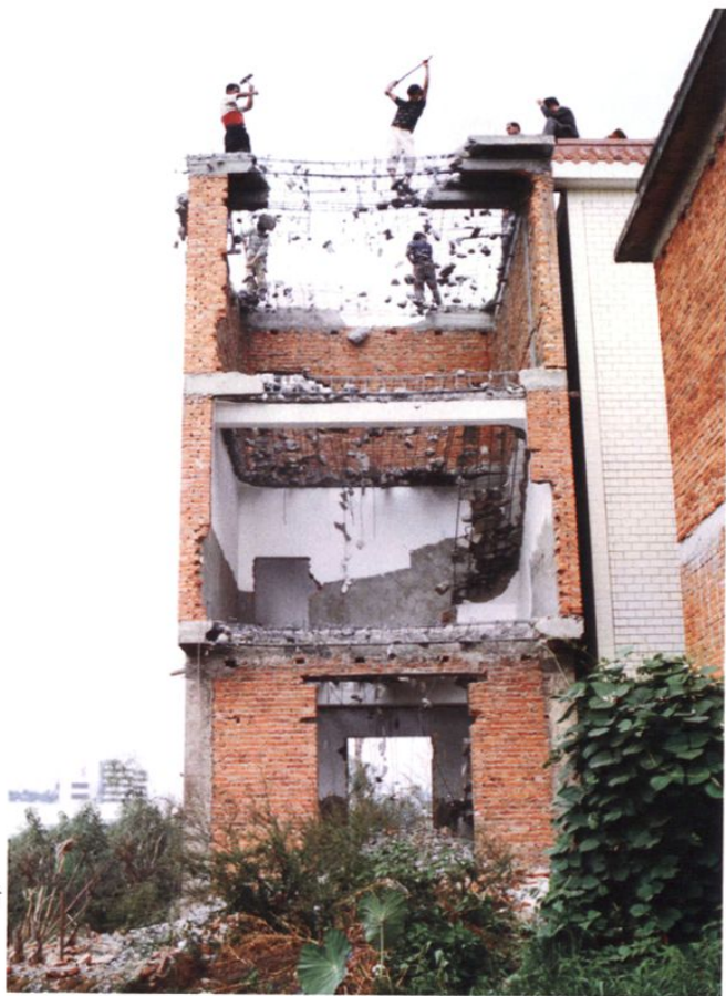
依法强制执行 人工拆除违法建筑
