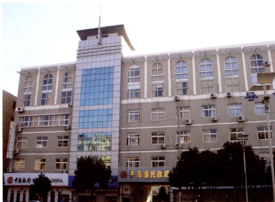
宁海县民政局办公大楼
