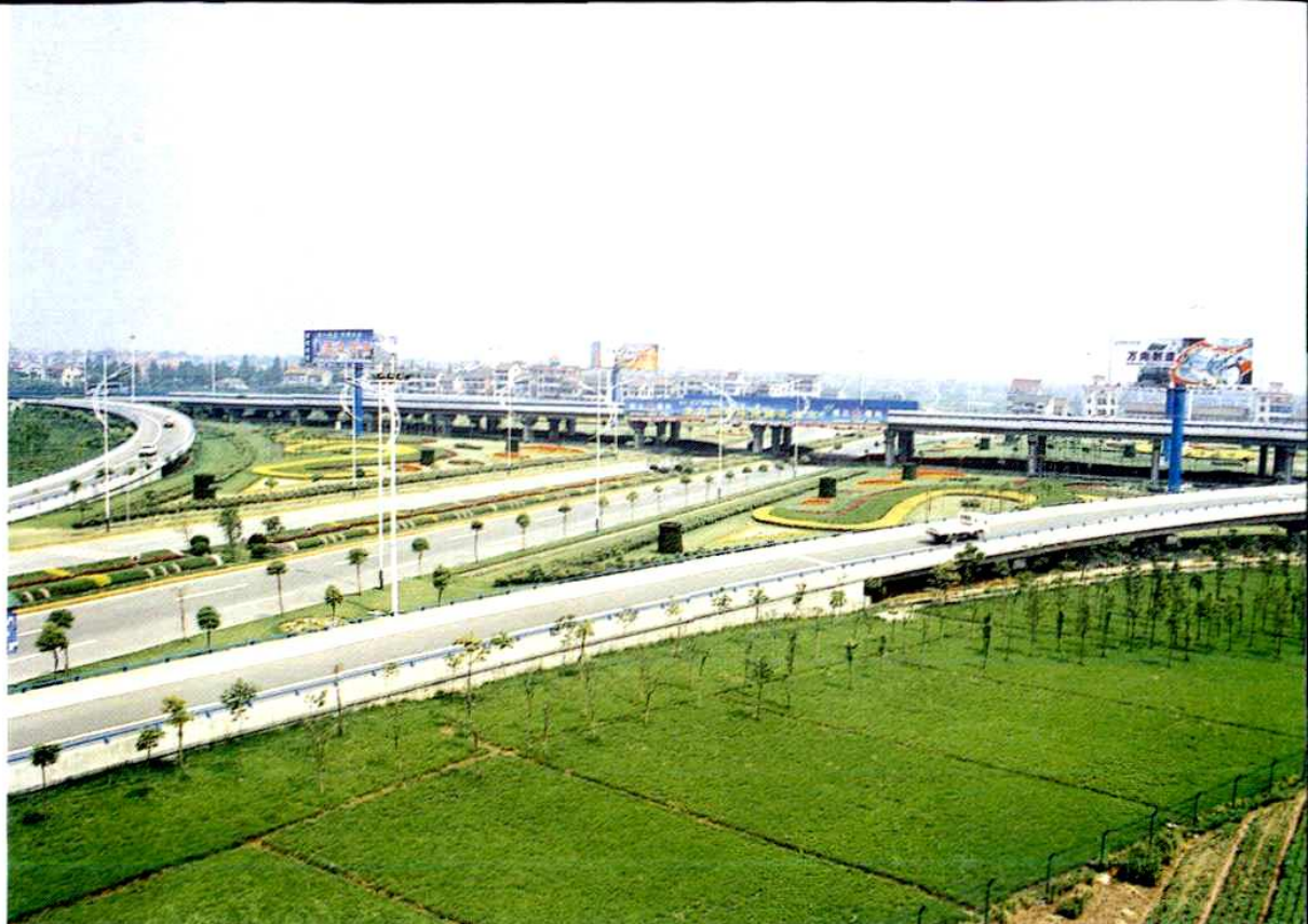
萧山机场高速公路立交桥
