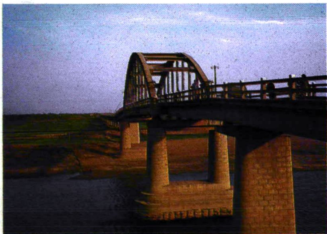
运河武城大桥
