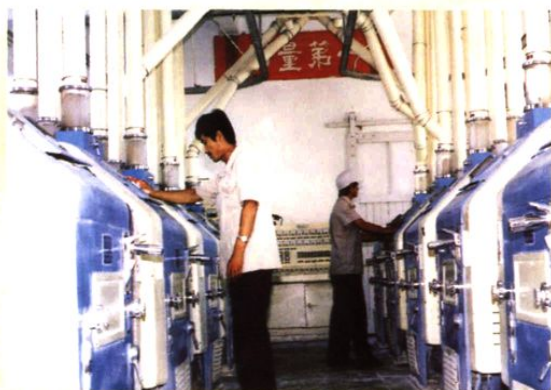
面粉厂制粉车间
