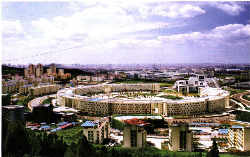
◎ 位于济南高新技术产业开发区的齐鲁软件园（2005年8月）
