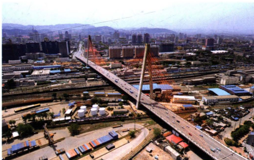
◎ 纬六路跨铁路斜拉桥 (2010 年 5 月)
