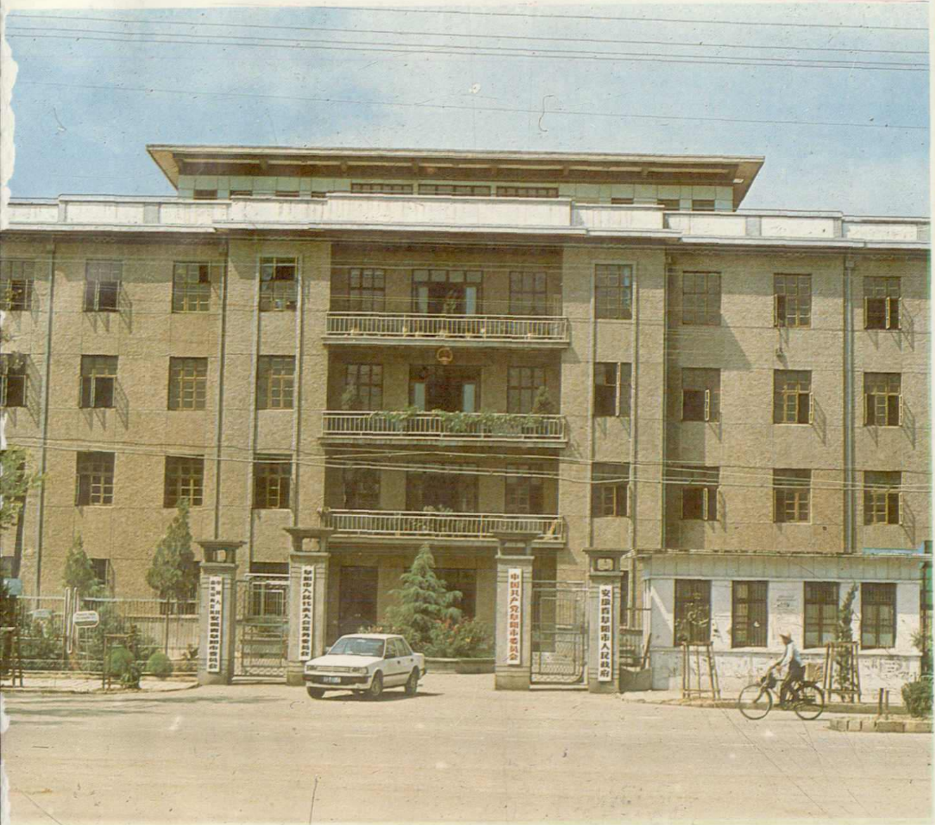
阜阳市政府办公大楼
