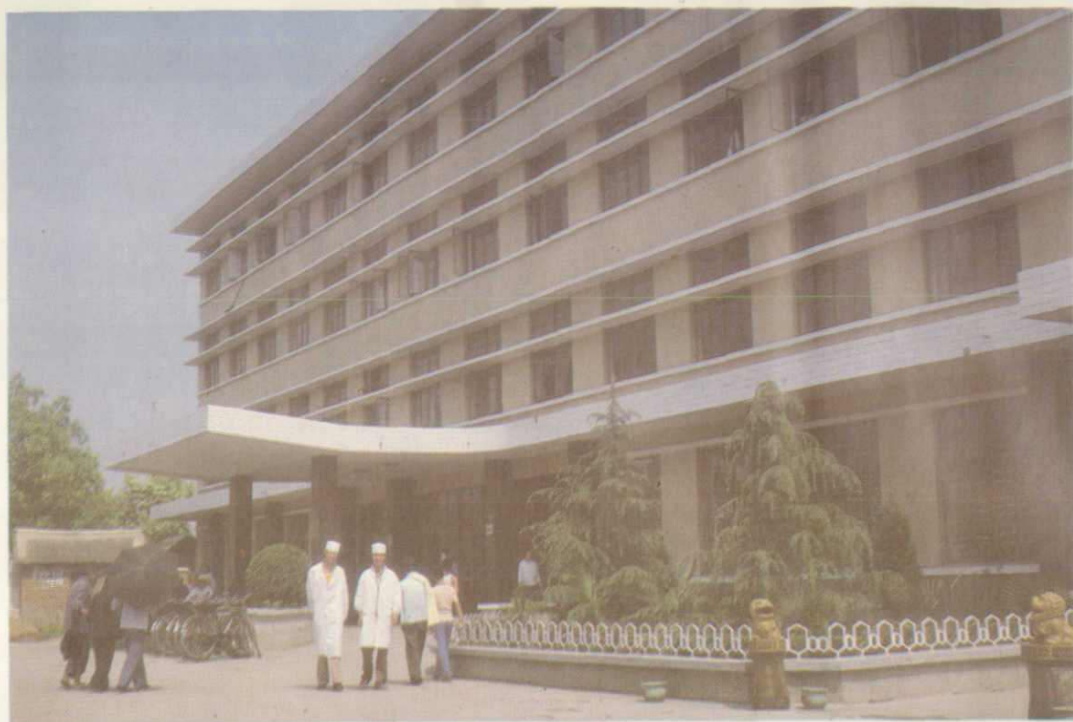
阜阳地区医院门诊部大楼
