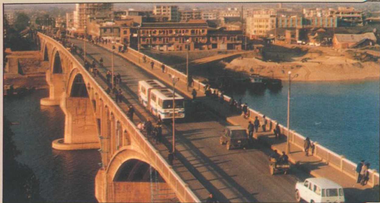
益陽資江大橋
