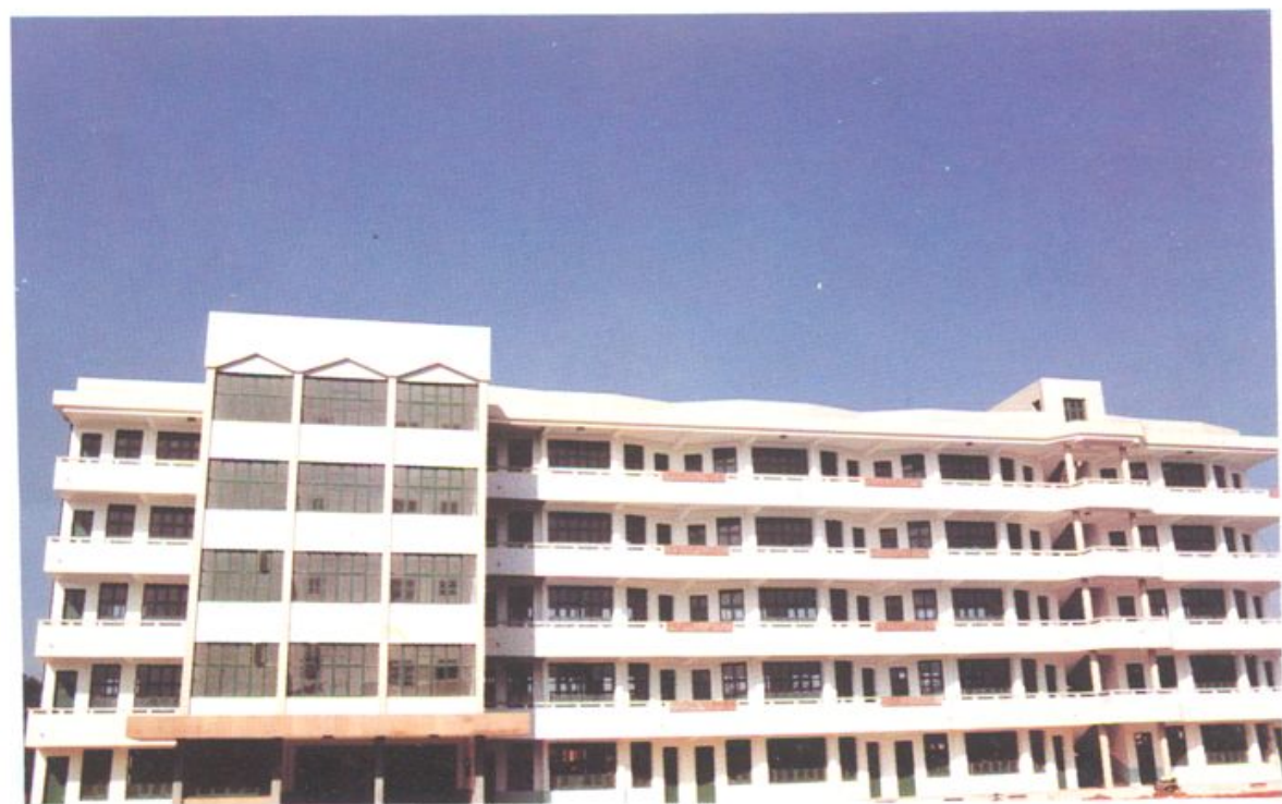
市九中教学楼（郊区中学）
