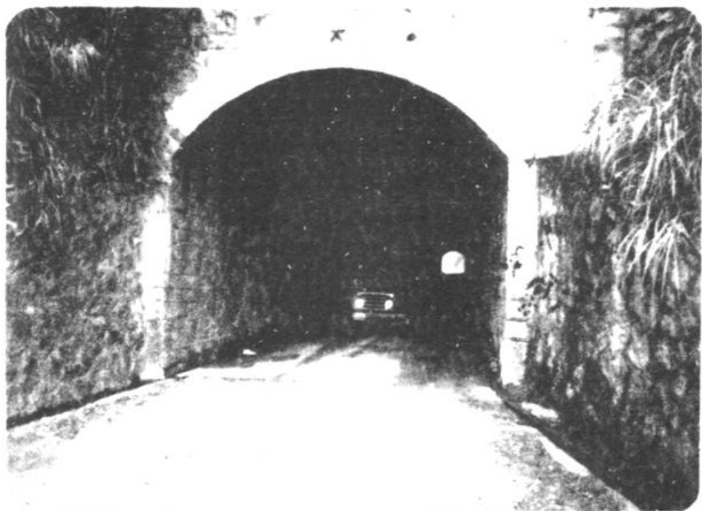
沙县高砂乡朝阳公路隧道
