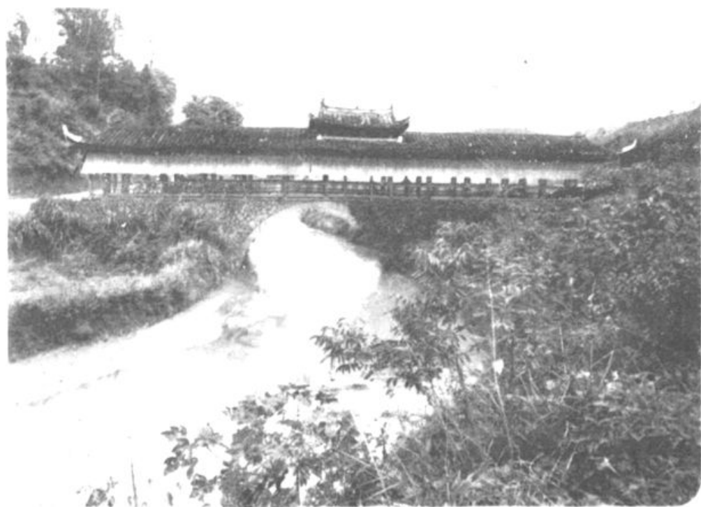
沙县进谷古桥
