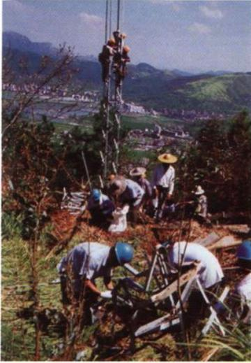
2004年8月, 抢修遭台风破坏的温江 3553 线 20 号铁塔
