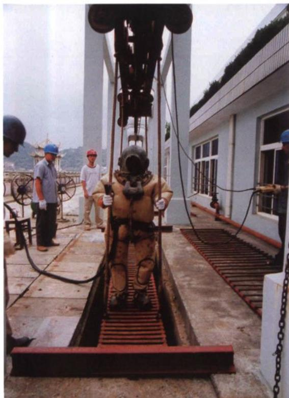
潜水员下水清理机组检修闸门门槽
