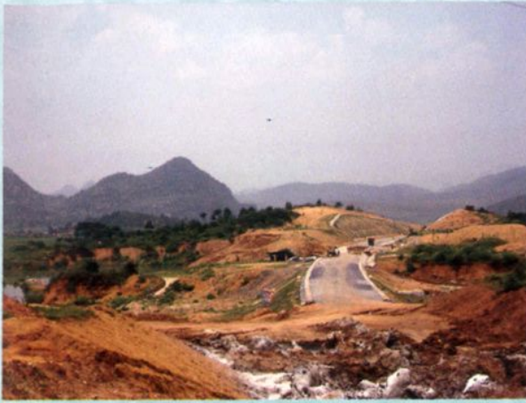
2004年12月15日，洛湛铁路广西段开工动员大会在望高镇举行，该路段计划于2008年竣工。县境内全长15.30千米。图为正在建设中的洛湛铁路钟山段。
