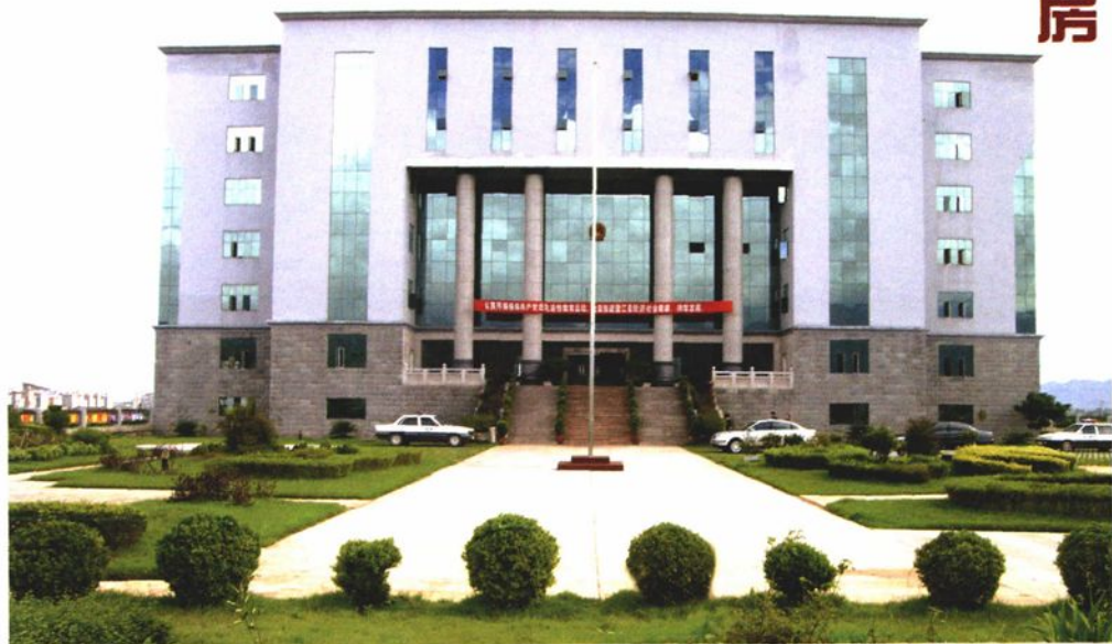
新建办公办案和业务技术大楼
