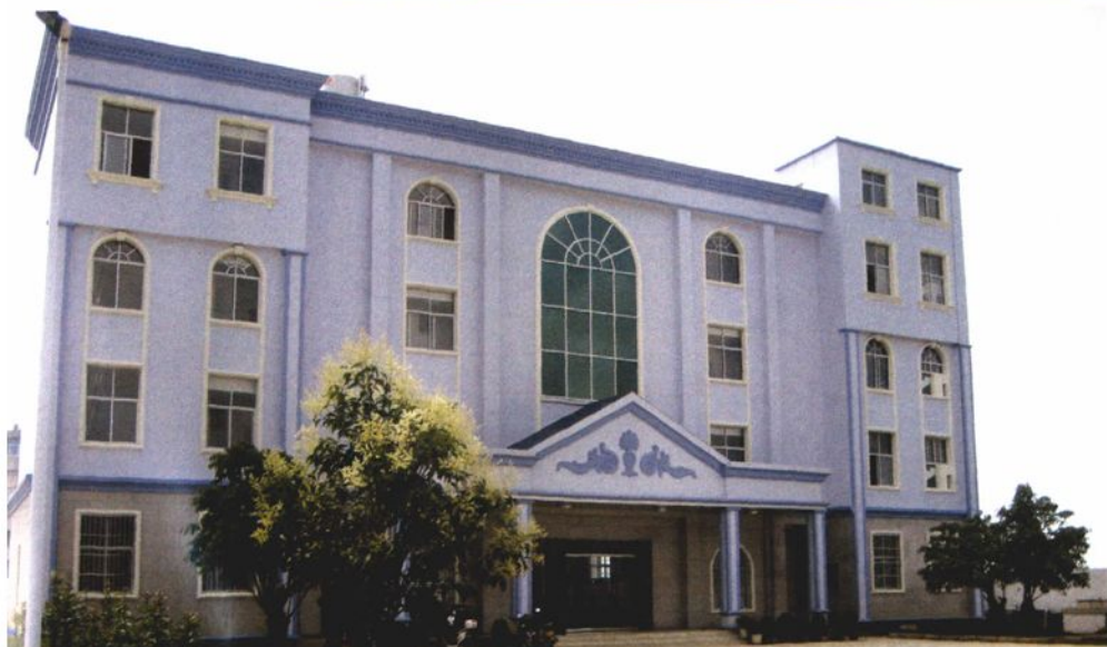
新建附属综合楼
