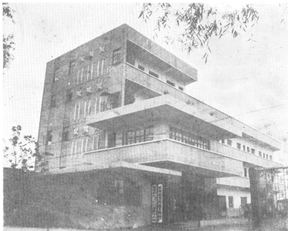
武进县第二建筑公司邹堰分公司办公楼
