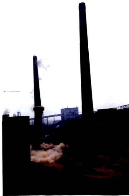
对被关停小机焦炉的烟囱采取定向爆破措施
