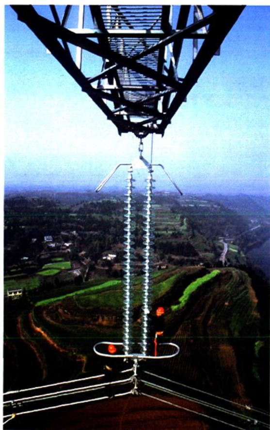
500千伏自贡—重庆线路施工现场
