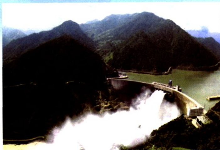
1999年12月4日，总装机容量330万千瓦，6台机组全部建成投产的二滩水电站大坝
