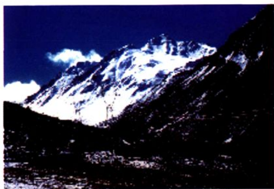
中国第一条高海拔、重冰区500千伏输电线路——四川二滩送出工程的500千伏输电线路跨越大凉山重冰区
