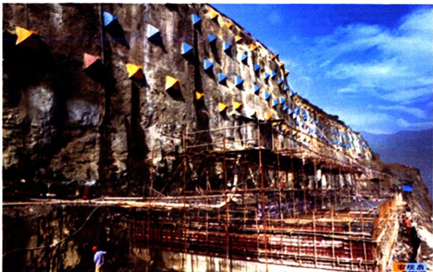
溪洛渡水电站坝肩开 挖工程一角
