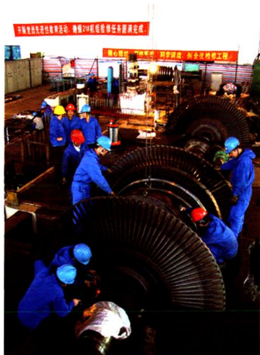
内江发电总厂白马发电厂21号机组改造
