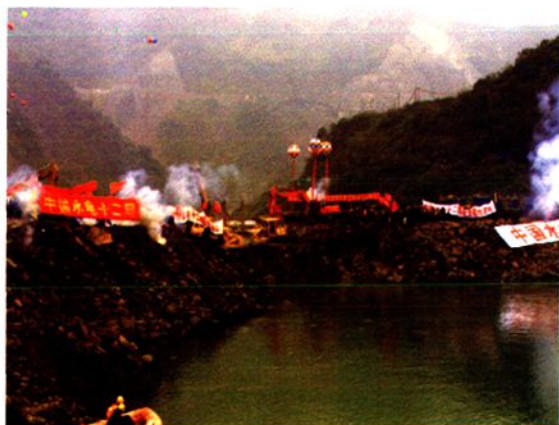
2002年11月23日，紫坪铺水电站截流
