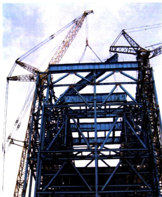
江油发电厂 2 \times 33 万千瓦扩建工程于1991年12月12日建成投产后，全厂总发电装机容量达到88.4万千瓦，为20世纪四川省装机容量最大的火电厂。上图为江油发电厂33万千瓦机组厂房外景；中图为电厂办公区一角；下图为33万千瓦机组吊架安装现场
