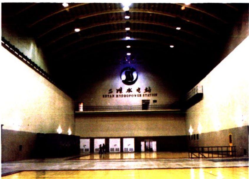
单机容量55万千瓦的 二滩水电站机房
