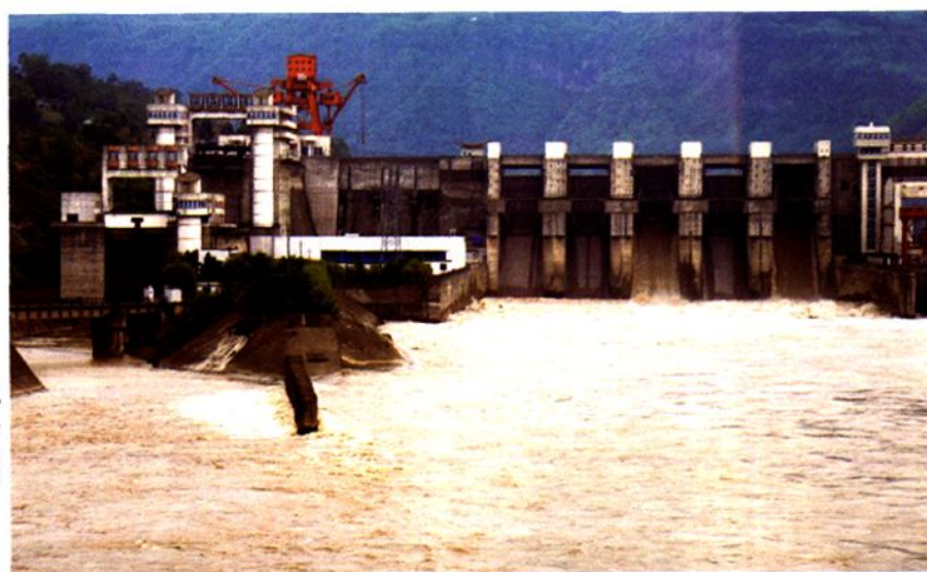
1992年第一台机组发电，1994年12月全部竣工的铜街子水电站（总装机容量60万千瓦）
