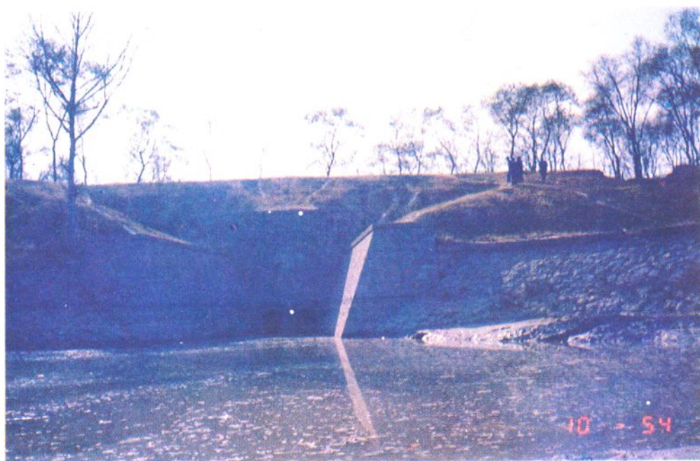
城湖大堤放水闸
