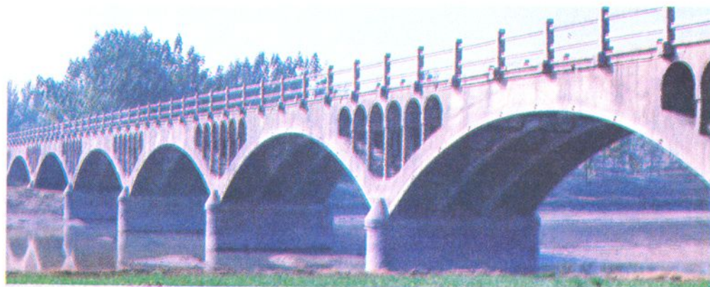
东鱼河双曲拱大桥
