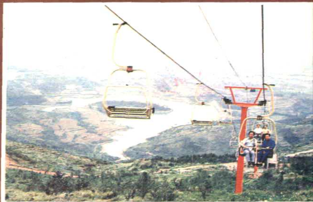
客运架空索道
