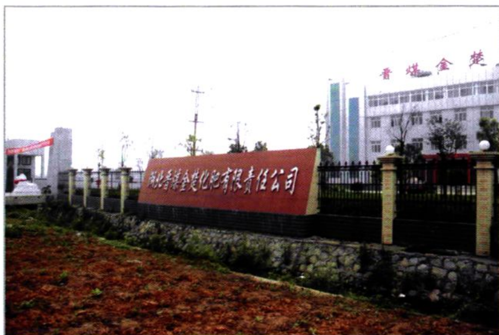
湖北晋煤金楚化肥有限责任公司一角
