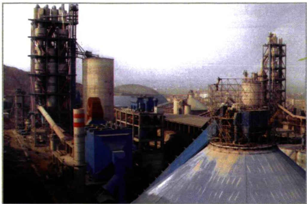
钟厦公司日产5000吨干法旋窑生产线
