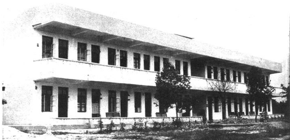
潭下镇中心卫生院
