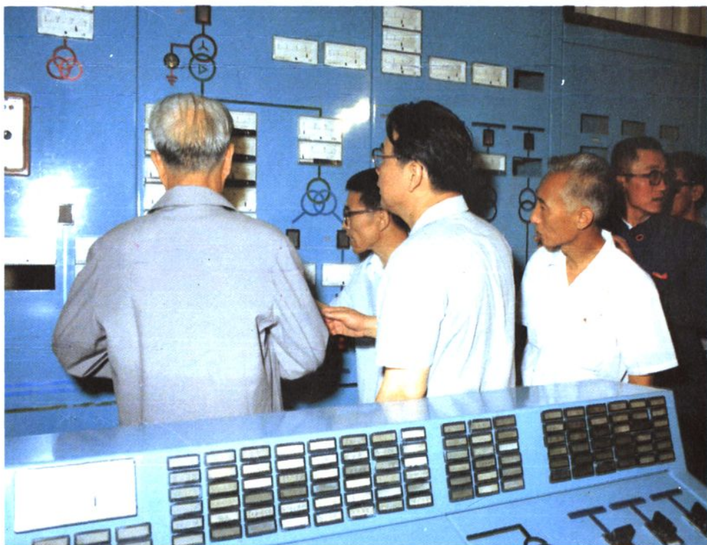
万里、李鹏副总理在大同二电厂一单元控制室视察运行状况
