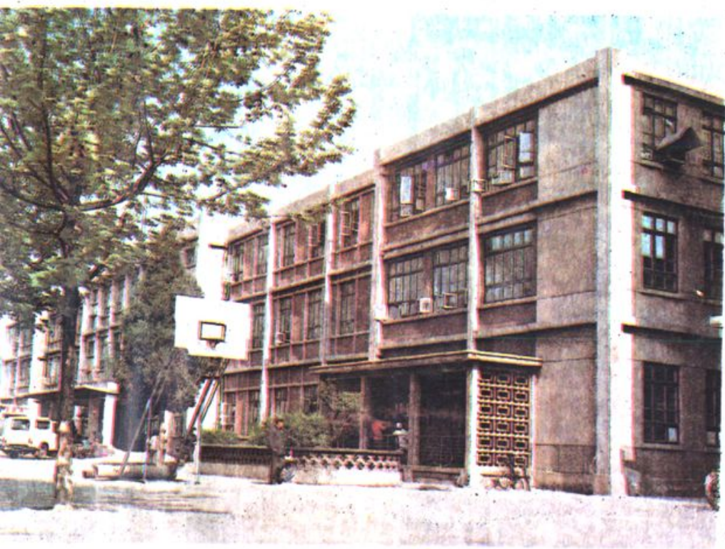
沂水中心医院门诊楼
