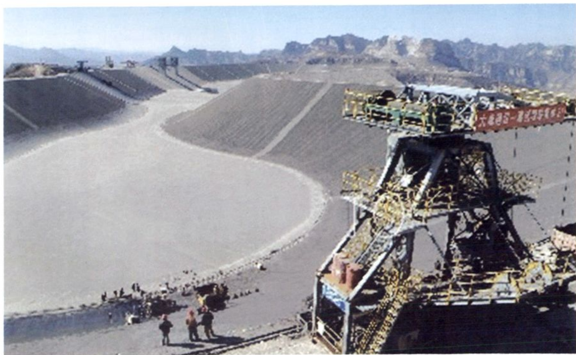
张河湾水库上库施工现场
