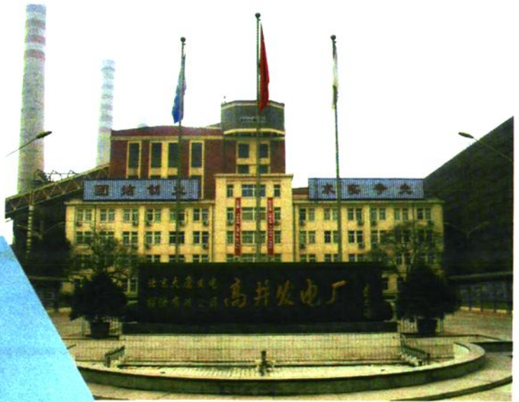
高井发电厂（1959 年建）
