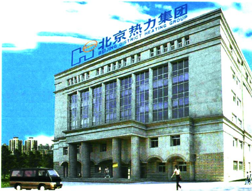
热力集团时期办公楼（2000年）
