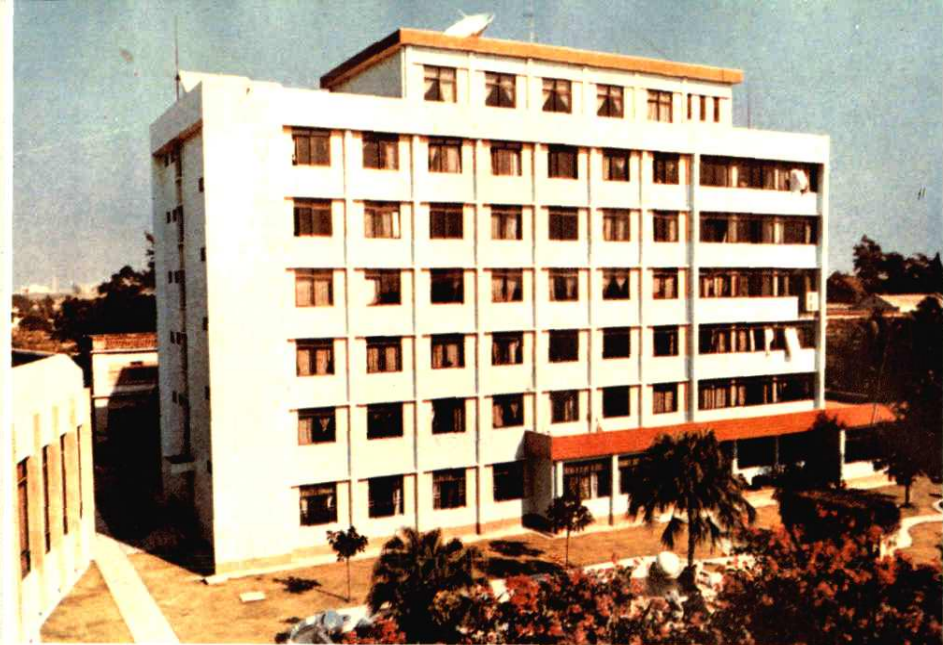
粤西农垦局办公大楼
