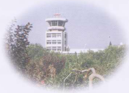
天津机场管制塔台
