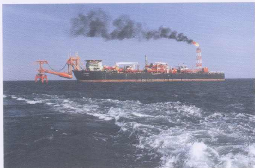
渤中34-2/4油田浮式储油装置—渤海长青号
