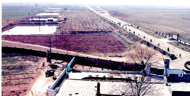
临猗县河务局屈村护岸工程
