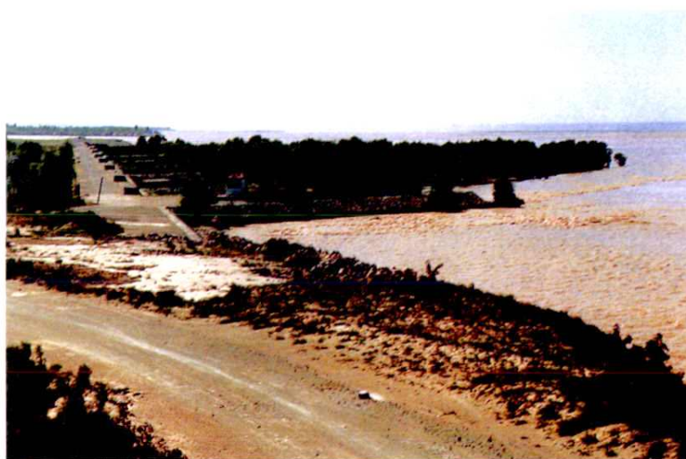
河津市河务局 小石嘴改建工程
