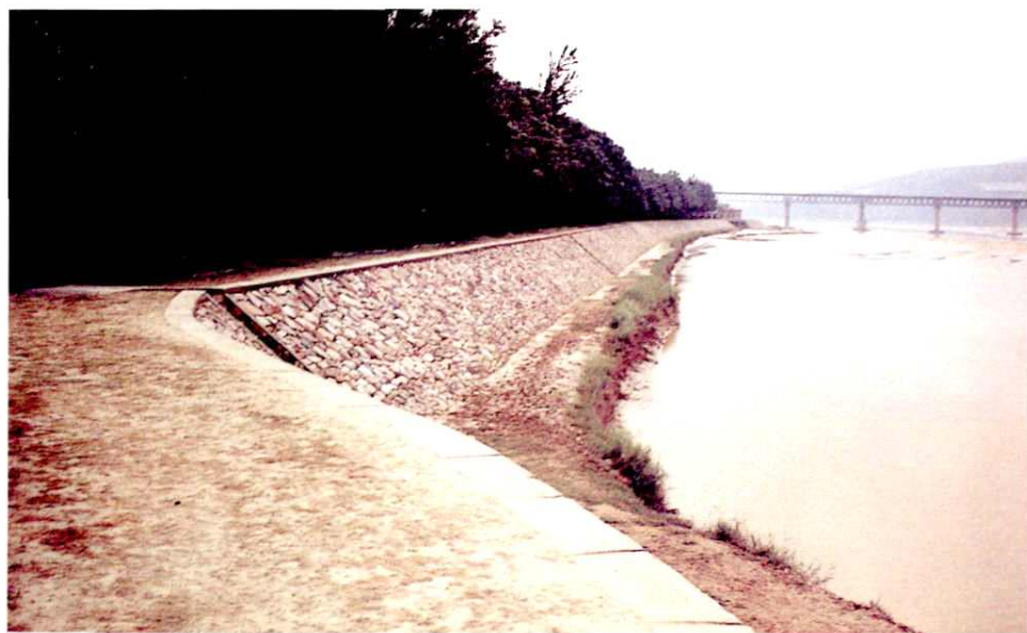
芮城县河 务局凤凰嘴护 岸工程
