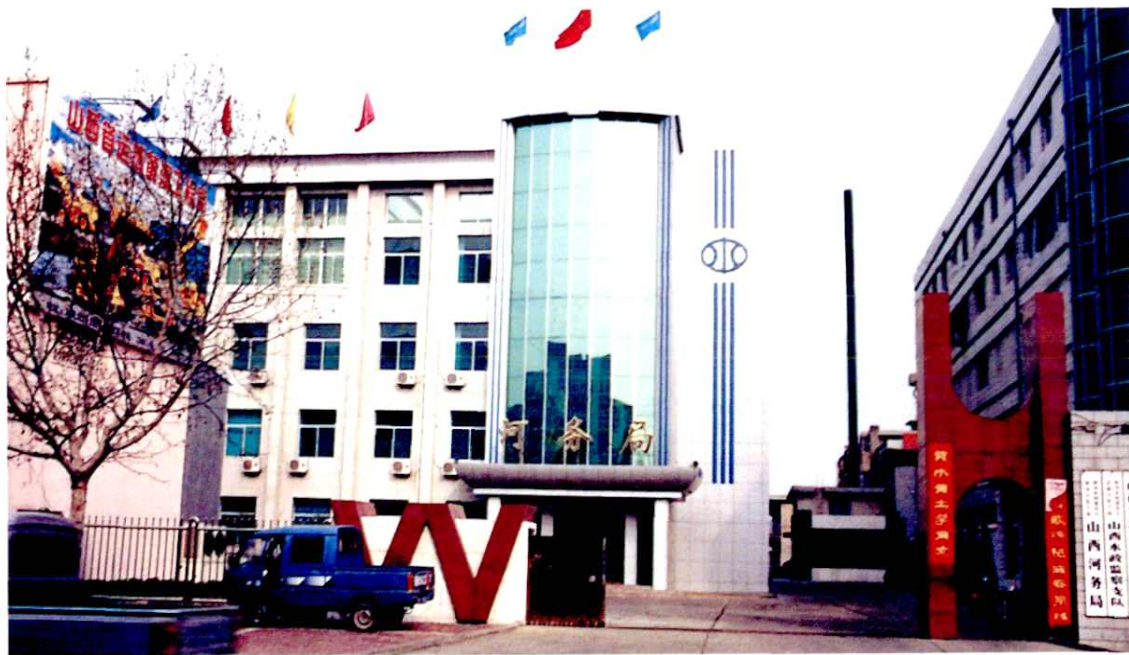
山西河务局机关办公楼
