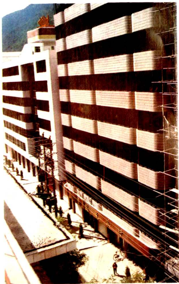
中国人民建设银行阿坝藏族羌族自治州中心支行行址
