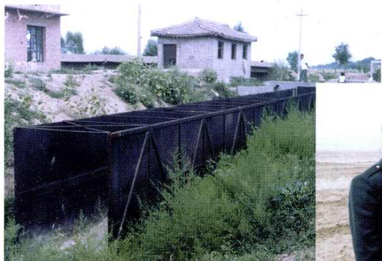
西九支磁窑河钢板活动渡槽
