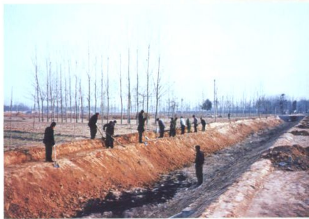
整修边坡，顺畅边沟
