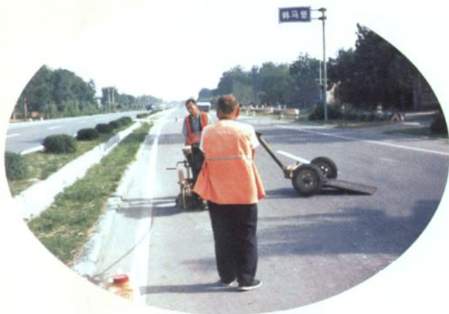
挖补坑槽，平坦路面
