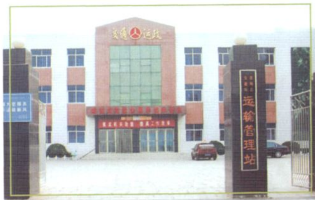
运输管理站办公楼及服务大厅
