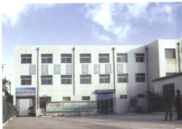
地方公路管理站办公楼
