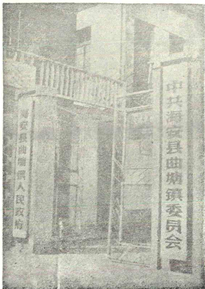
中共海安县曲塘镇委员会、 曲塘镇人民政府办公大楼 (一九八六年)
