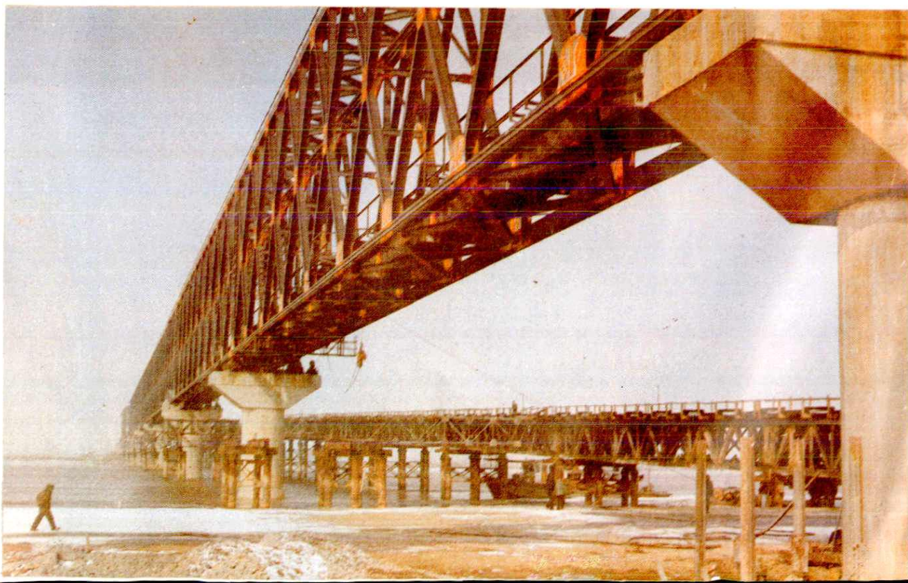
施工中的长东黄河铁路大桥
