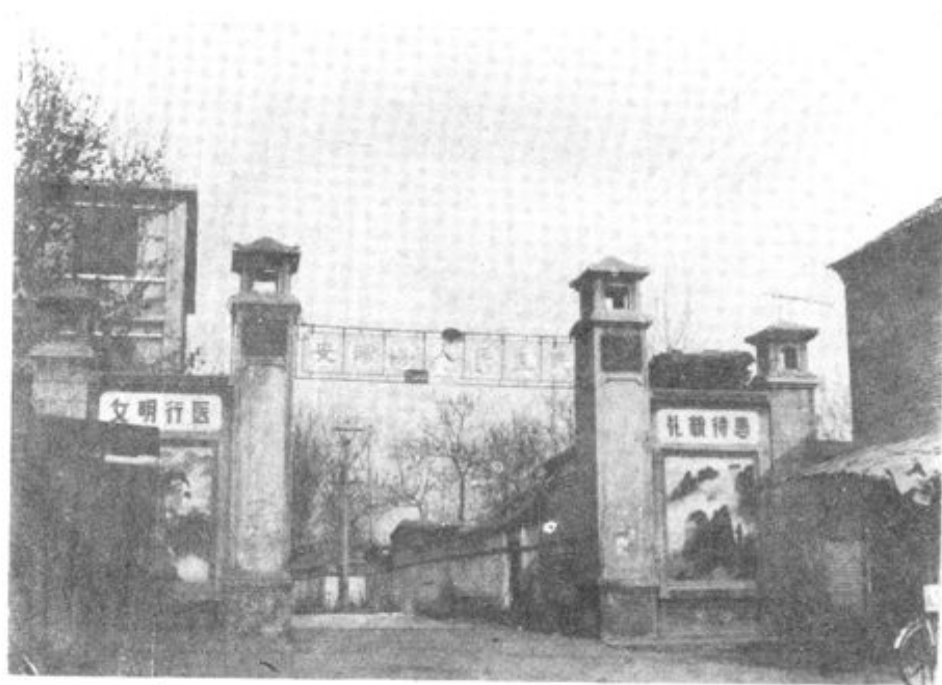
安阳县第一人民医院
