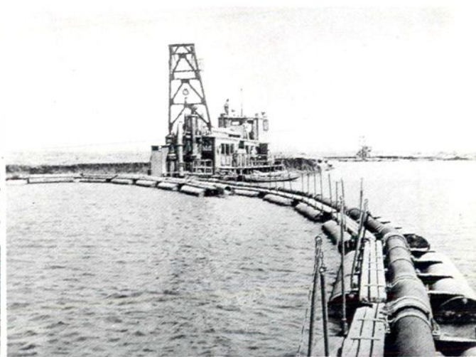
▼ 一九七九年,用挖泥船对北排河海口段进行清淤
