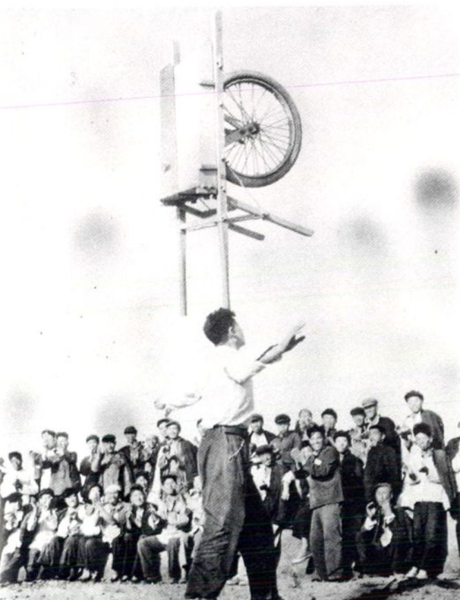
◀ 吴桥县治河工地小憩
