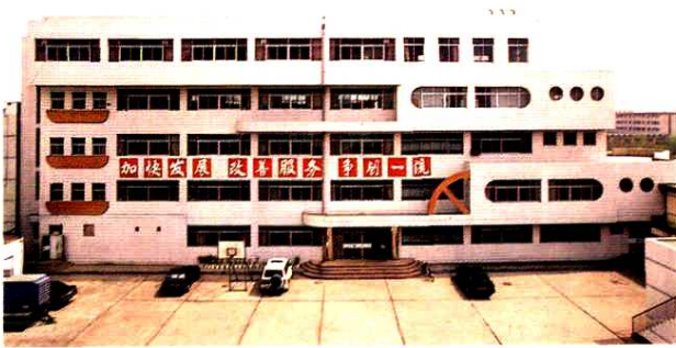
石嘴山市邮电局办公楼
