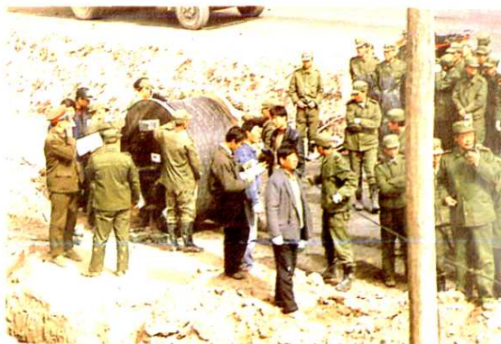
京呼银兰光缆石嘴山段部队支援建设
