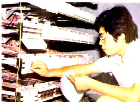
112 测量台的作业现场
