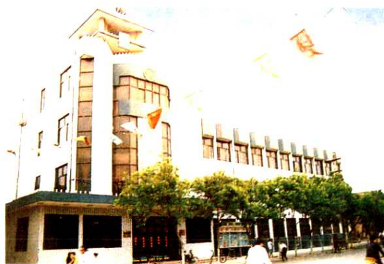
石嘴山区邮电局通信楼
