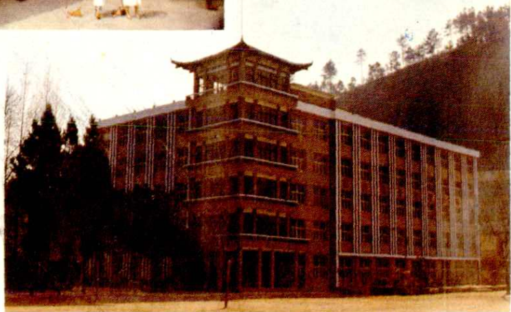
▼ 开化中学教学大楼
