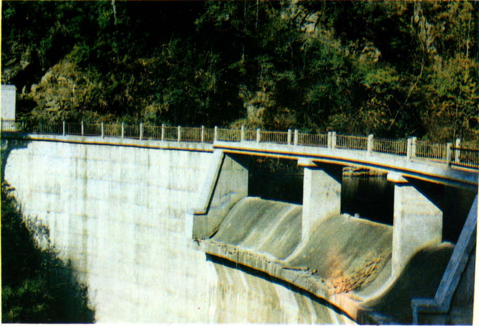
响水岩水库拱坝
