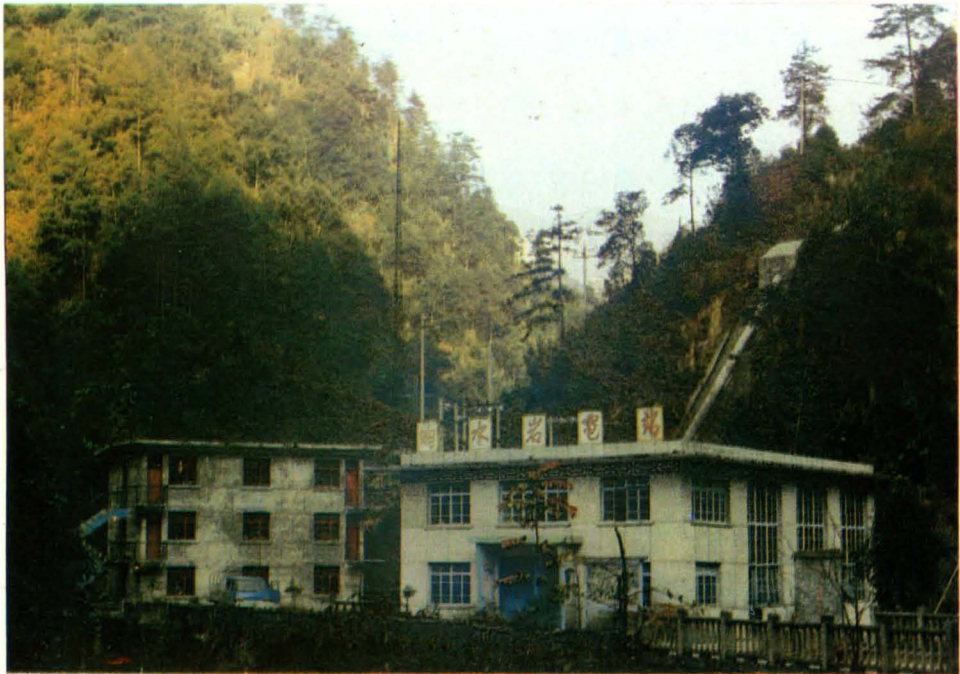
响水岩电站厂房
