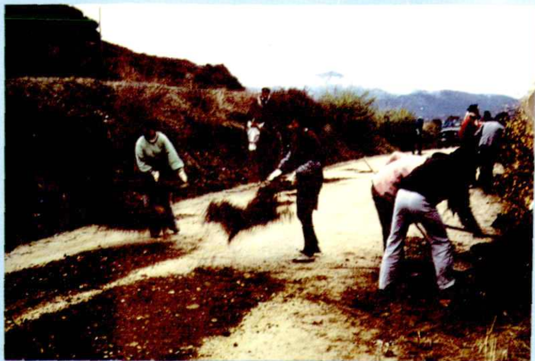
同乐式道班松潘养路段上磨道班工人在 养护通向童话世界九寨沟之路（万晓玲摄）
