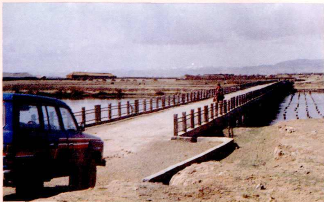
阿坝州最长的公路大桥——唐克白河大桥
