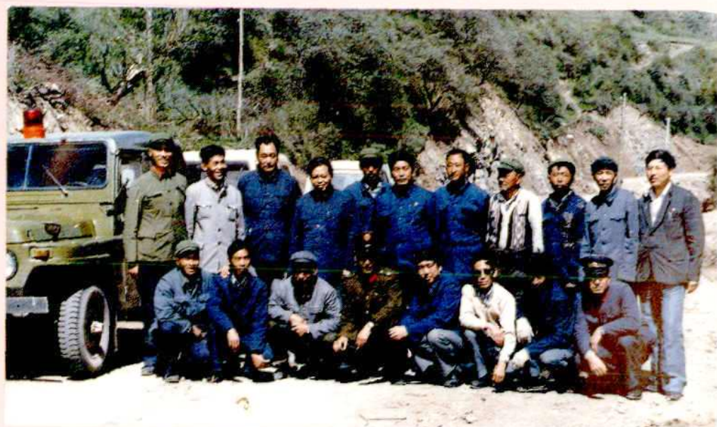
阿坝州政协主席木瓦三郎(后左三),检查粮、棉、布以工代赈修建公路工程时,在工地与壤塘县筑路指挥部领导留影。
