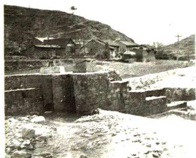
杨河电站引水渠首工程
