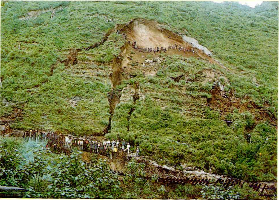
双石铺宝成铁路(105km+650)处滑坡重力侵蚀现场)
