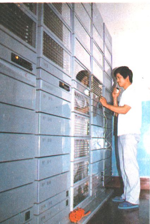
全厂已使用自动电话图为交接台
