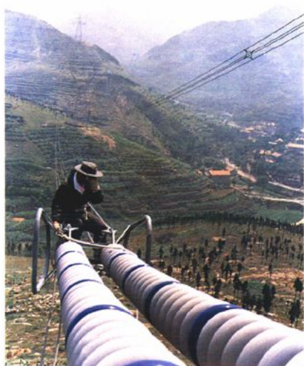
500 千伏线路带电作业
