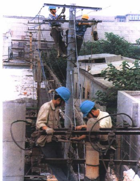
配电线路维修
