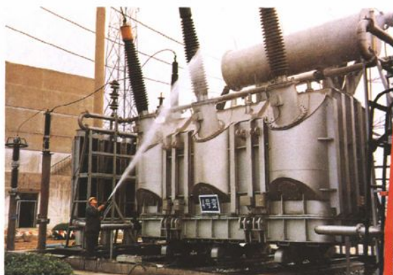
220 千伏变压器带电水冲
