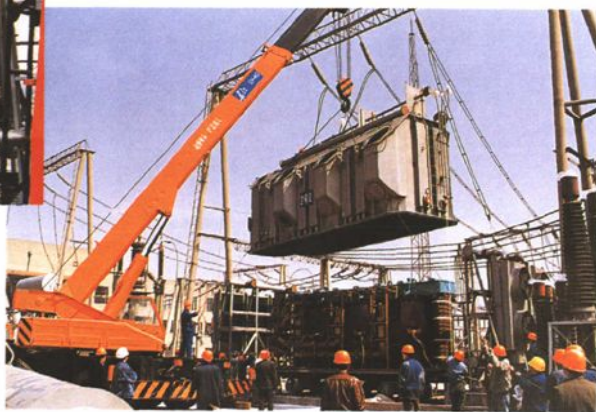
220 千伏变压器吊罩检查
