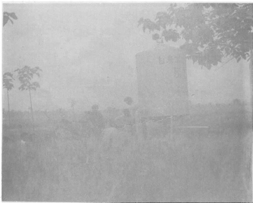
农村新建自来水压力罐
