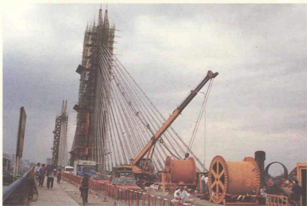
广州市市政工程维修处对海印大桥换索工程进行监理
