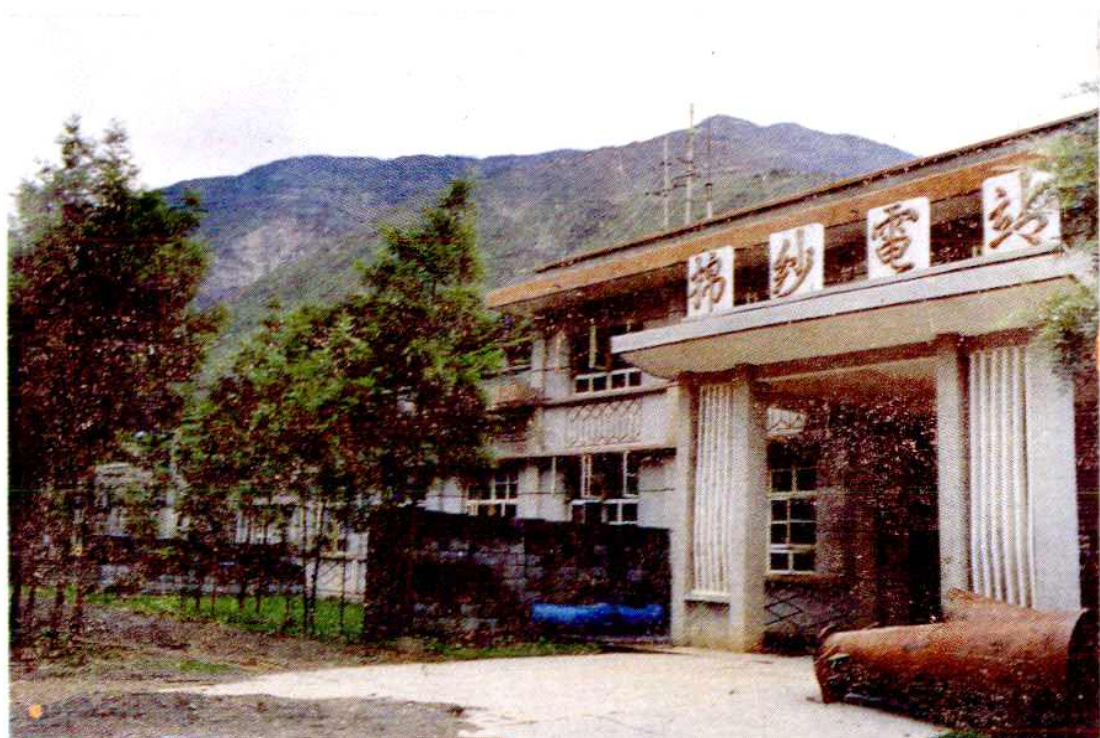
▲巧家棉纱电站
