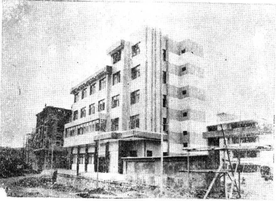
建设中的中国人民银行三穗县支行办公楼
