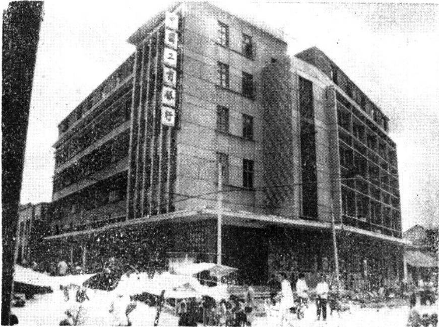
中国工商银行三穗县支行办公大楼（县人行在一起办公）
