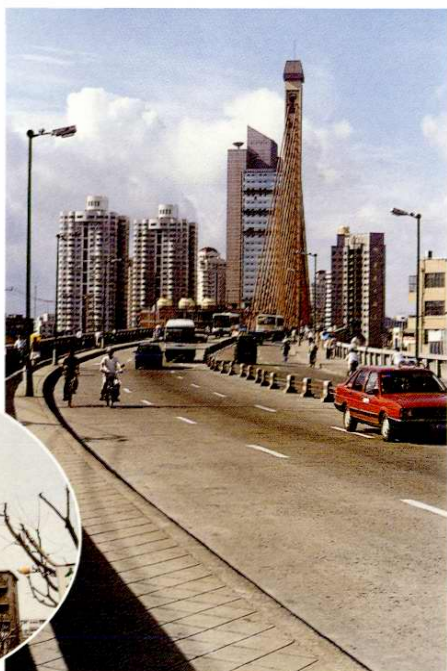
恒丰路立交桥
