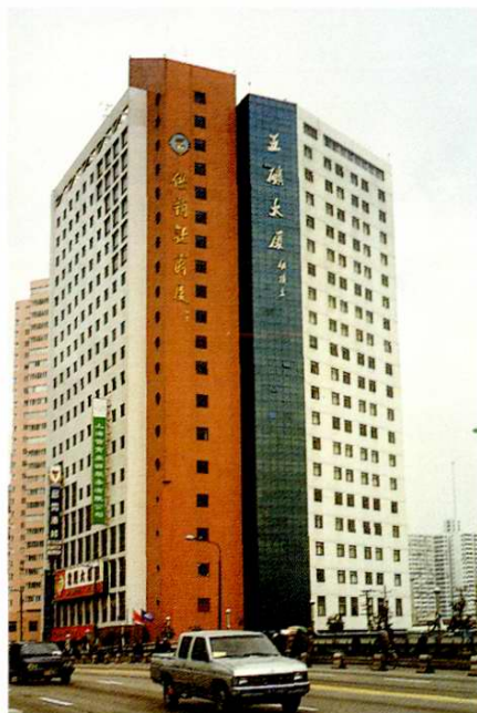
供销社商厦 五矿大厦
