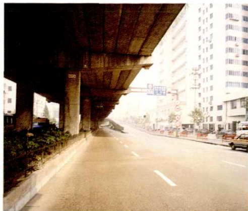
内环高架道路
