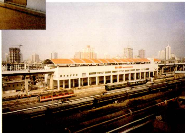
轨道交通三号线宝山路站
