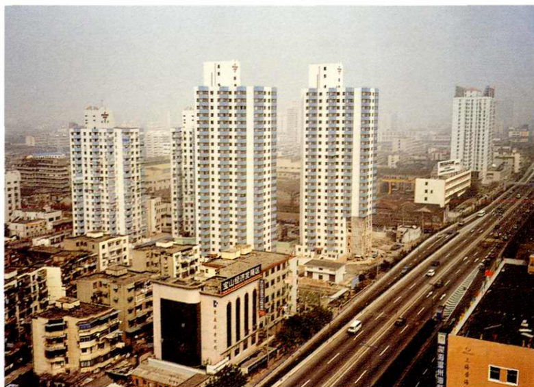
中山北路高层住宅楼
